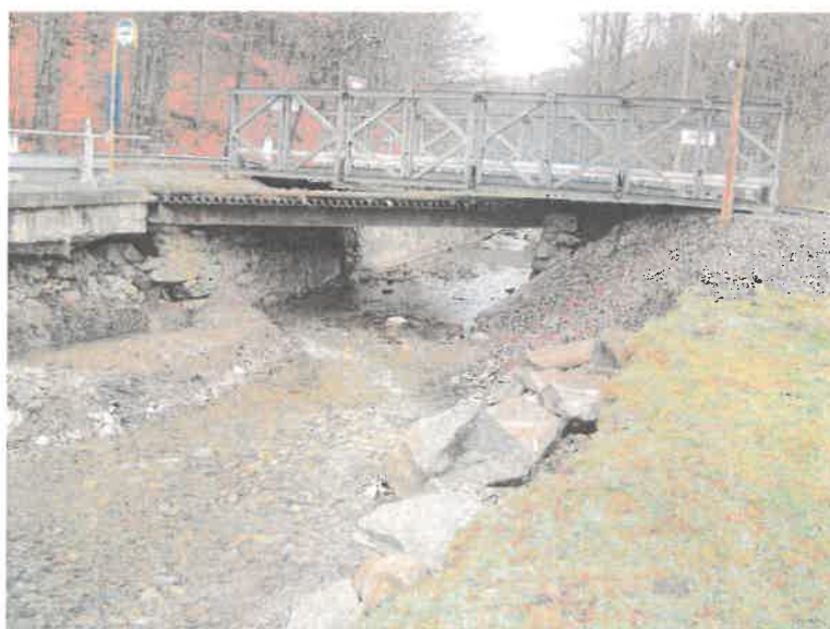
Pohled na mostní provizorium z pravé strany (povodní)
