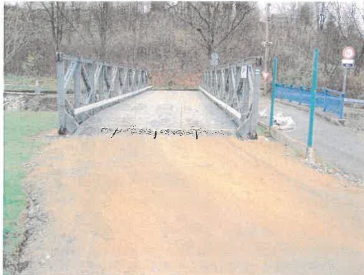
Pohled na MP proti směru staničení k sil. I/60 - absence SDZ DZ viz. text 1. HPM
