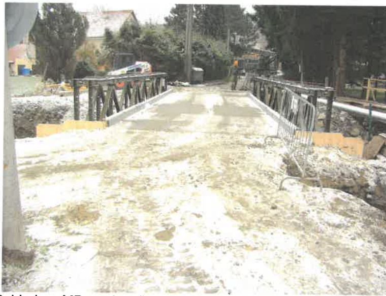
Pohled na MP proti směru staničení k sil II/453
