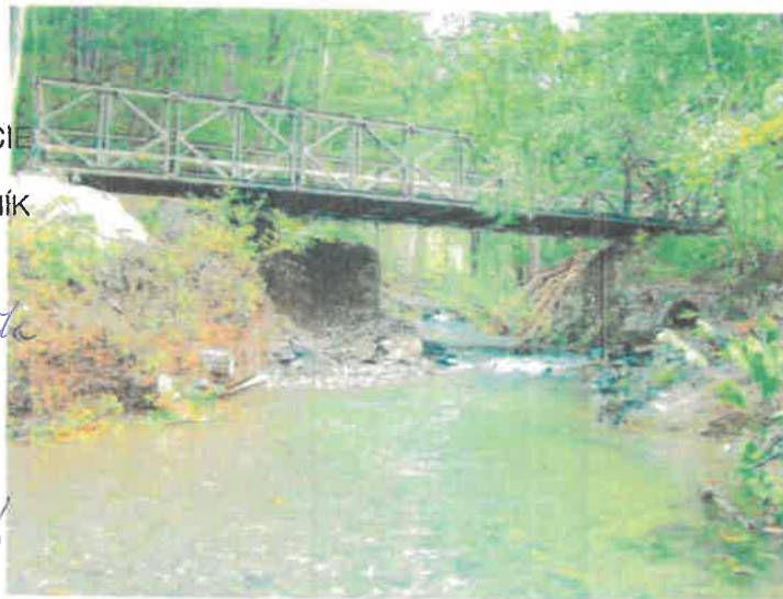
Pohled na mostní provizorium z pravé strany (povodní)
