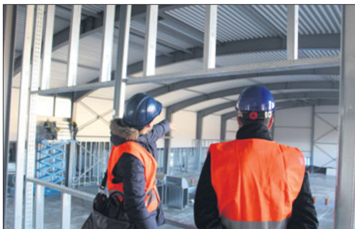
Stavební práce pokračují uvnitř haly.
