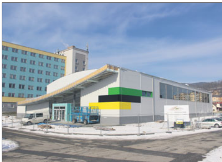
Nová sportovní hala bude dokončena letos na jaře.
