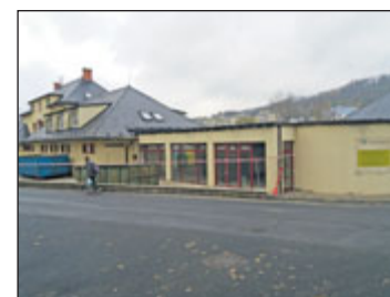
Přípravné práce. Foto: R. Kapustka
