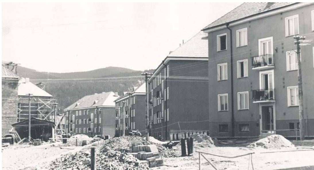
Výstavba sídliště na Mahenově ulici v roce 1965 (pokládání inženýrských sítí do vozovky). Vlevo rozestavěné třípatrové domy. Zdroj foto: Státní okresní archiv Jeseník
