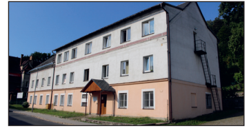
Sídlo bývalého učiliště v Jeseníku.
