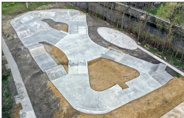
Stavba nového skateparku.
