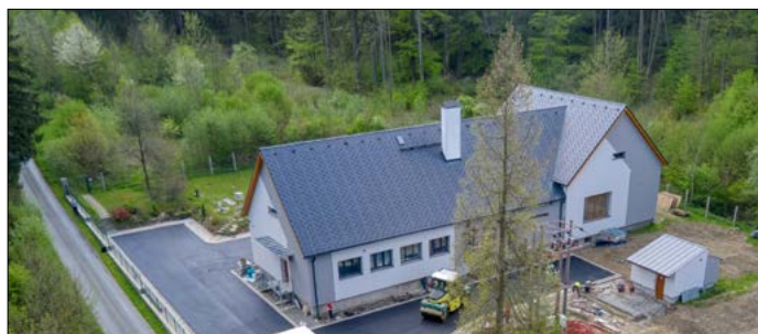
Úpravná vody v Adolfovicích. Foto: Tomáš Neuwirth.
