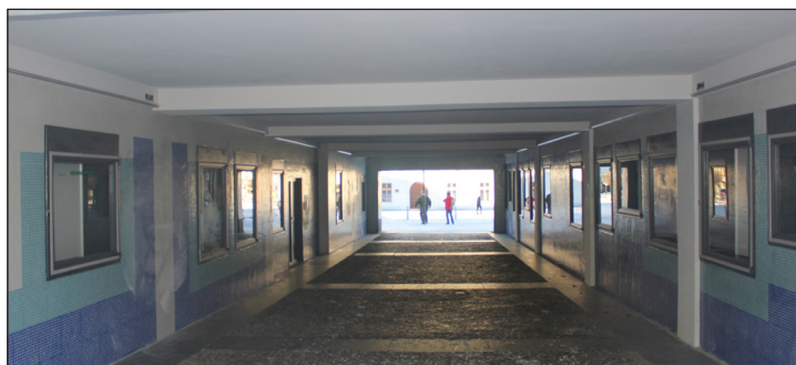
Stavební práce na průchodu na náměstí jsou dokončeny. Foto: Lucie Tenekedz
