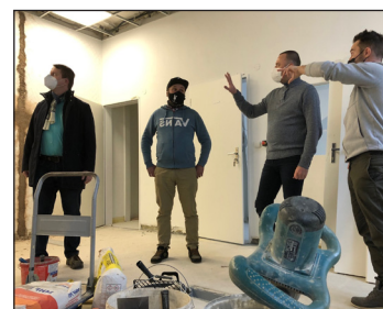
Rekonstrukce ambulance v plném proudu. Foto: Jesenická poliklinika
