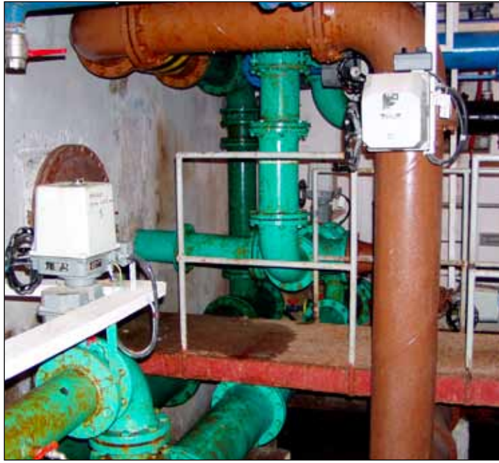
Rekonstrukce úpravní vody v Adolfovicích je nezbytná.
