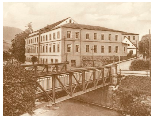
Secesní most přes řeku Bělou, 1920
