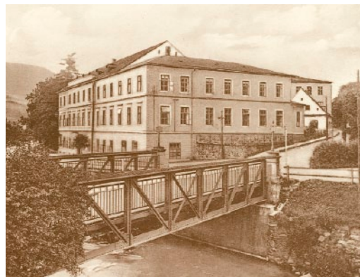
Jugendstilbrücke über den Fluss Bělá (Biele), 1920
