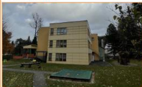
Analytická část – současný stav budovy
