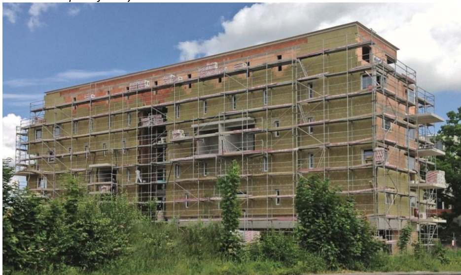
Obrázek 11: Ukázka zateplení fasády minerální vatou
