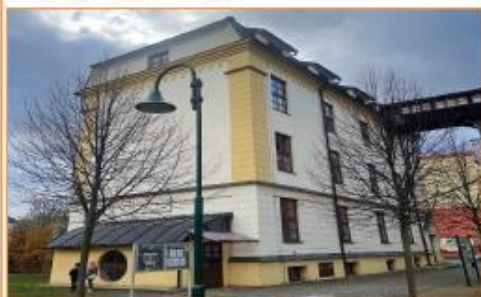
Analytická část – současný stav budovy Budova školní družiny.
