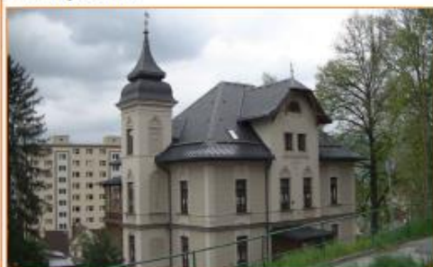
Analytická část – současný stav budovy Zrekonstruovaná budova školky.
