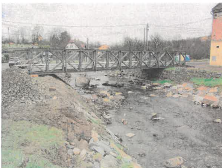
Pohled na mostní provizorium z pravé strany (návodní)
