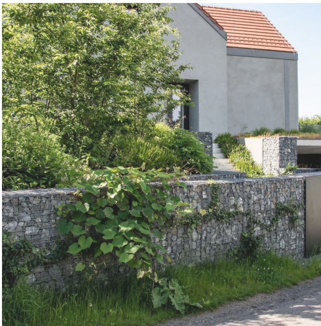
01a/ gabionový plot s popínavými rostlinami a vzrostlou vegetací
