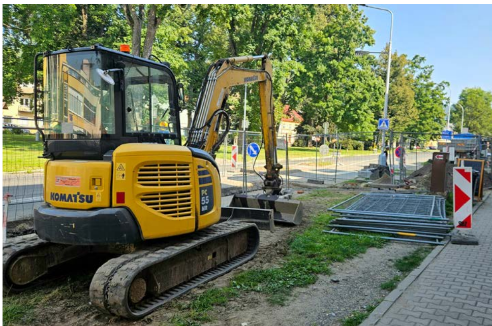
V létě začala na náměstí Svobody obnova plynovodu, na podzim se pak počítá s opravou chodníku.
