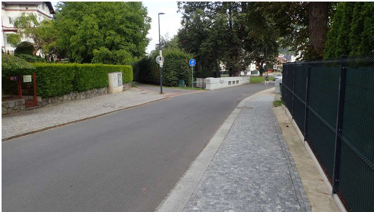
Fotografie č. 24 – křížení ul. Tyršovy s cyklotrasou č. 4 s nedostatečnými rozhledovými poměry
