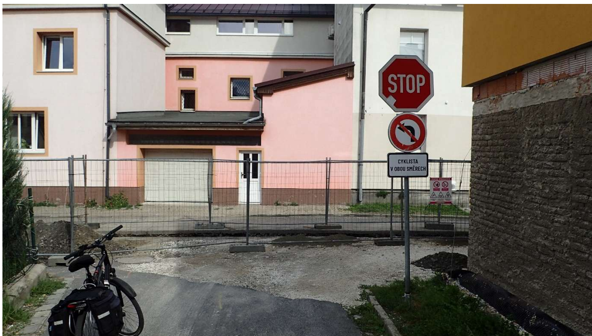
Fotografie č. 14 – cyklotrasa končící v oplocení staveníště – ul. Žižkova
