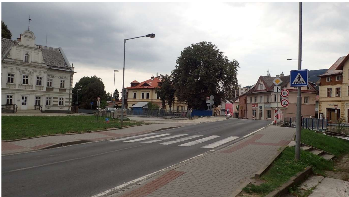
Fotografie č. 5 – stávající most na ul. Lipovské přes Staříč, pohled k ul. Fučíkové vč. provizorní lávky
